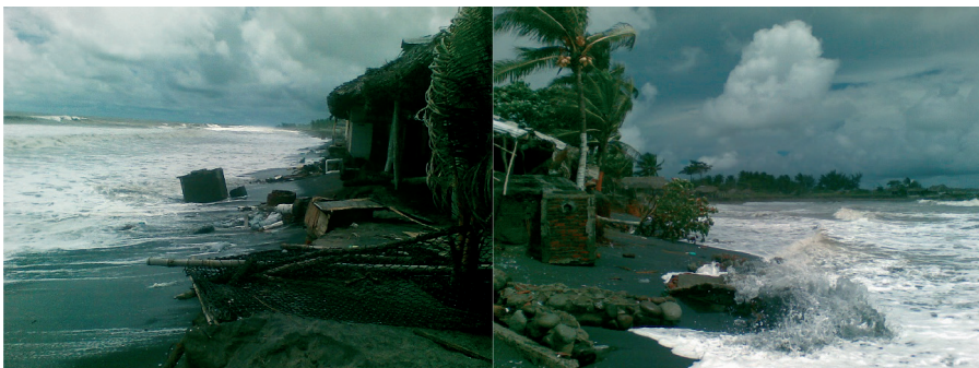
Figura 2. Daños a la infraestructura costera en la comunidad de Puerto Madero, Tapachula, Chiapas.
