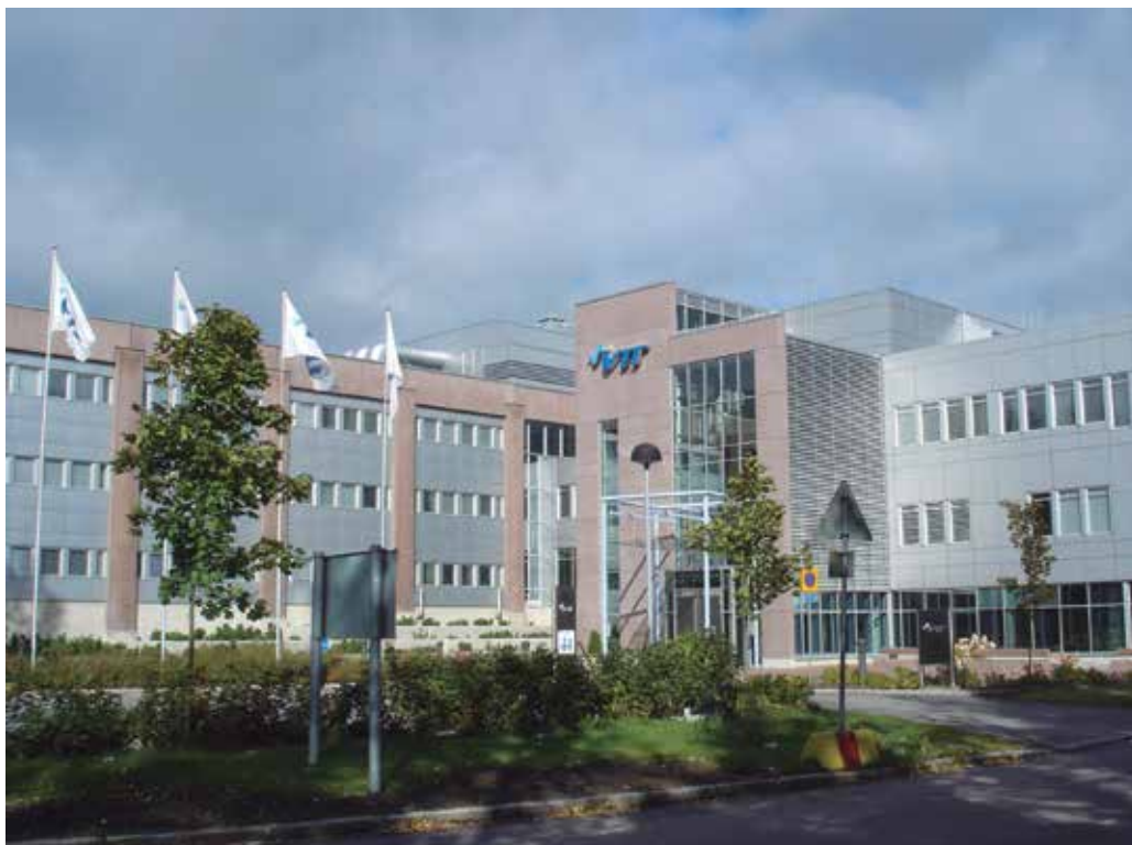
CENTRO DE INVESTIGACIÓN TÉCNICA FINLANDÉS UBICADO EN HERVANTA, TAMPERE
