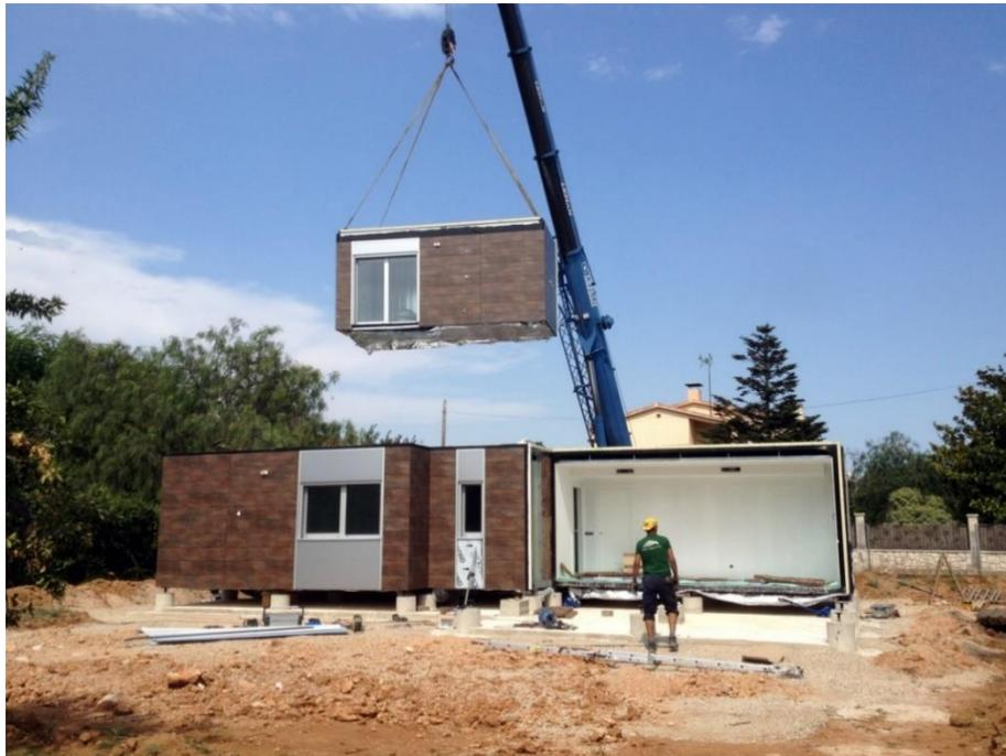
**Figura 11.** Ejemplo de transportación a sitio de una edificación de construcción modular (ARQHYS, 2016).
