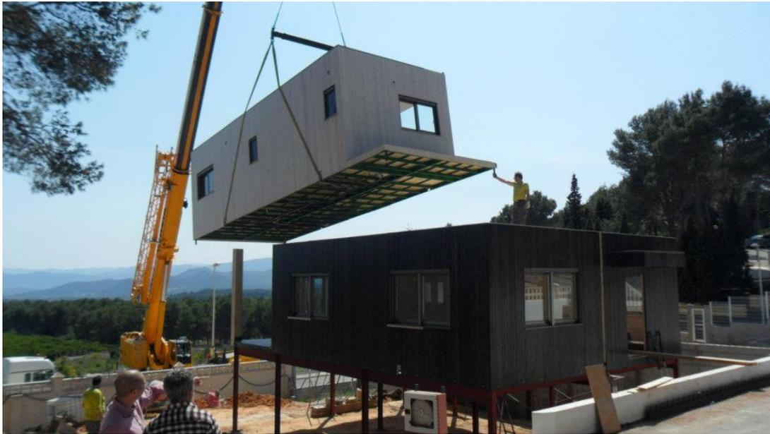
**Figura 12.** Ejemplo de transportación a sitio de una edificación de construcción modular (CasaNatura, s/f).
